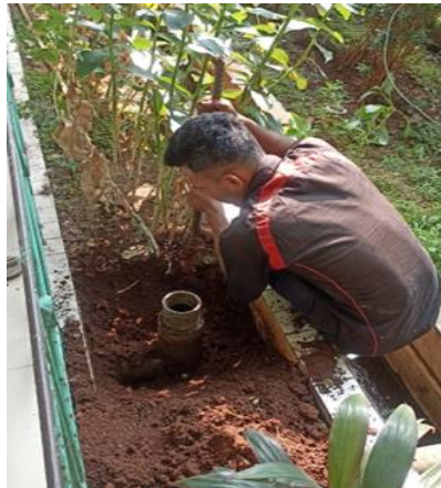
Gambar 2 Pengecekan Pipa Pembuangan
