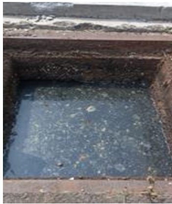
Gambar 1 Pengecekan Bak Kontrol
